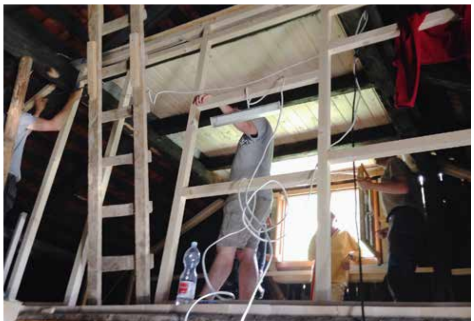
Einbau der neuen mäuse-sicheren Schlafkabine
