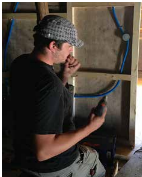
Thomas Feger war für den Einbau der Stromversorgung verantwortlich.
