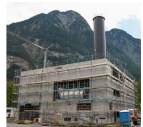
Rohbau Holzheizwerk Balzers
